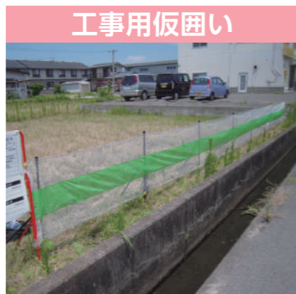
現場の仮囲い用のネット。
