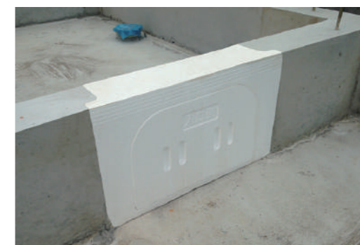
基礎打設時に埋め込みます。
